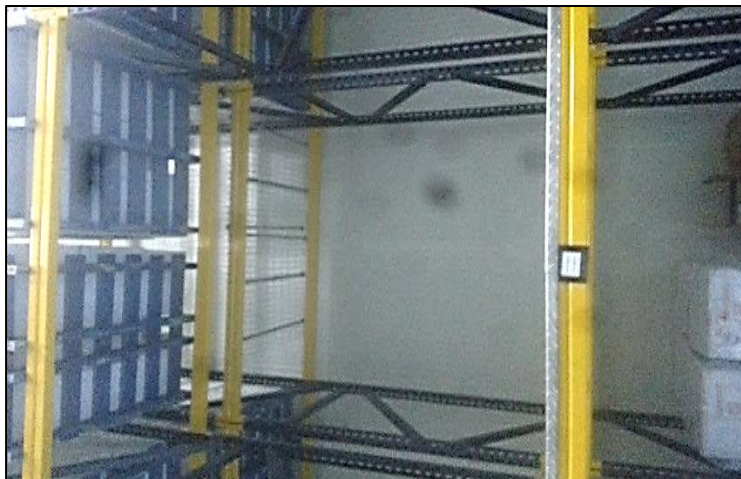
Ilustración No. 1. Estantería, Bodega Zona Franca, Ministerio de Salud y Protección Social.
